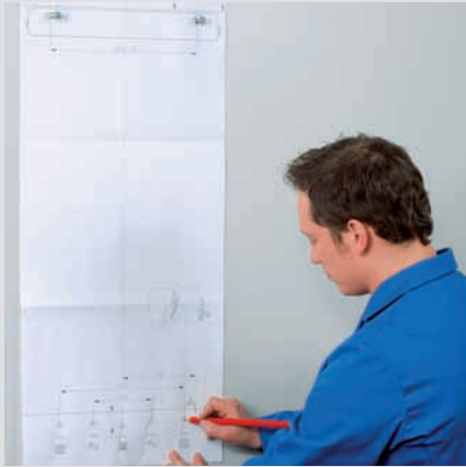
1 Αποτύπωση (σημάδεμα) βάση του σχεδίου εγκατάστασης
