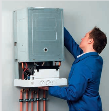
2 Εγκατάσταση (κρέμασμα) του λέβητα
